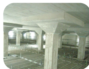
(下地処理完了)
