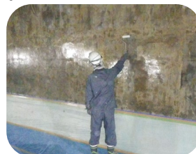
(プライマー塗布)
