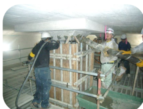
(コンクリート打設)
