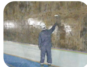
(プライマー塗布)
