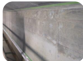
（下地処理完了）
